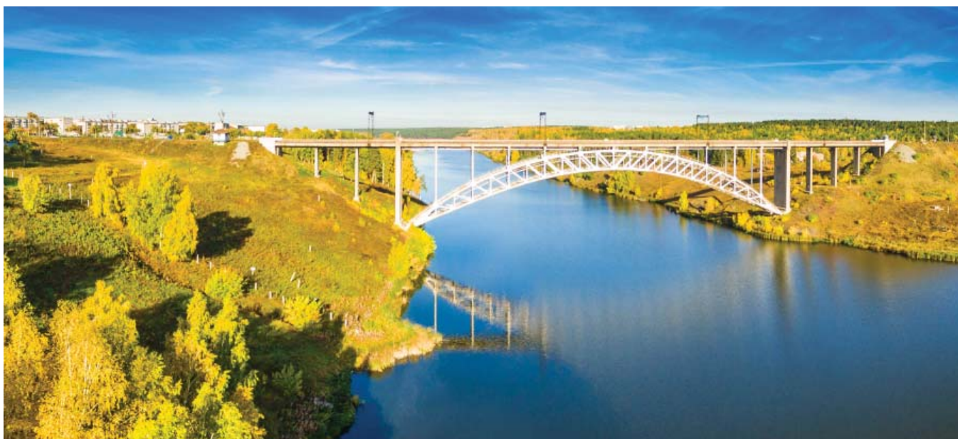
Ж.д. мост В.А. Росновского
